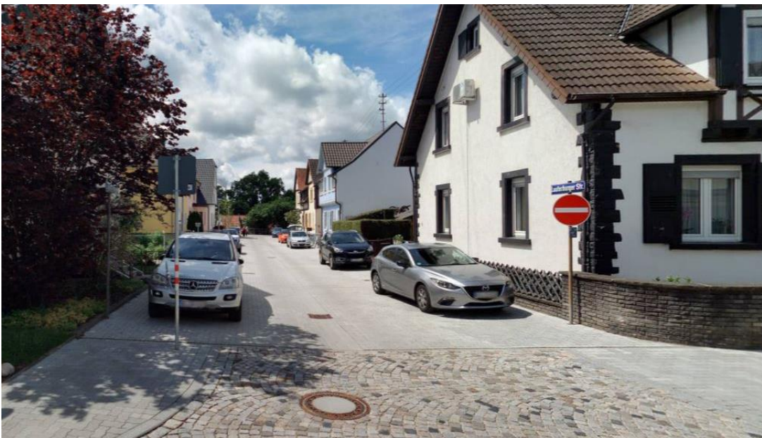
Abb.: Bereits fertig gestellte Lauterburger Straße im Sanierungsgebiet Alt-Knielingen
